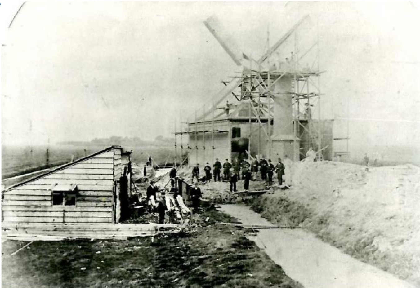
Foto bouw gemaal Dorppolder 1876
