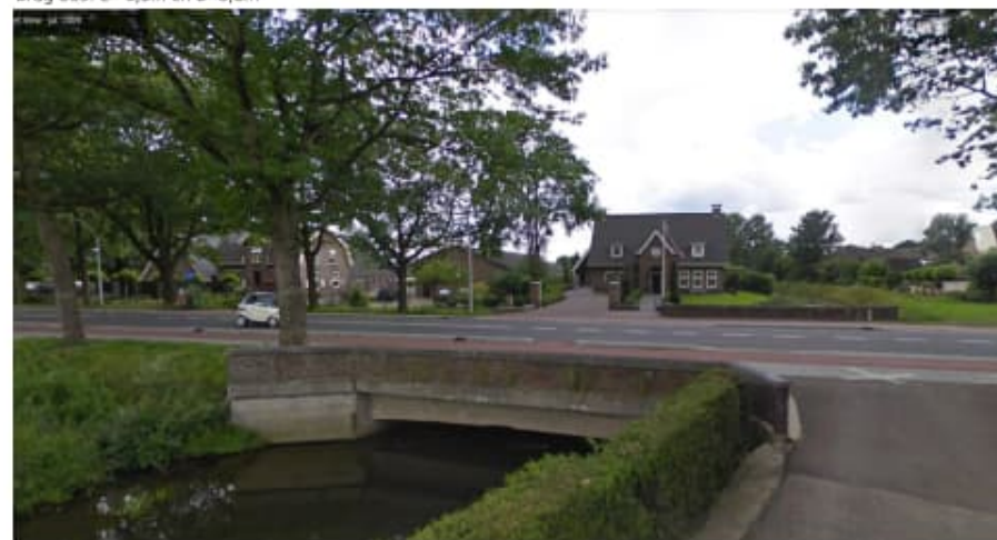
Betonnen dek, één overspanning, gemetselde borstwering en betonnen dekzerk, geknikte vleugelwanden
