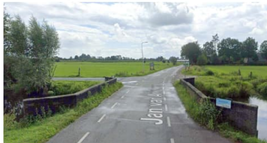
Brug 069: L= 6,5m en B=6,6m
