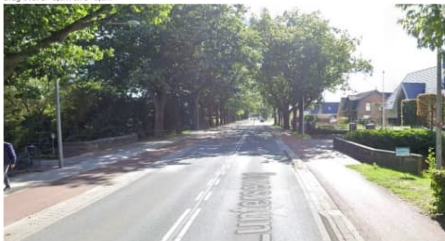
Brug 066: L=9,0m en B=17m
