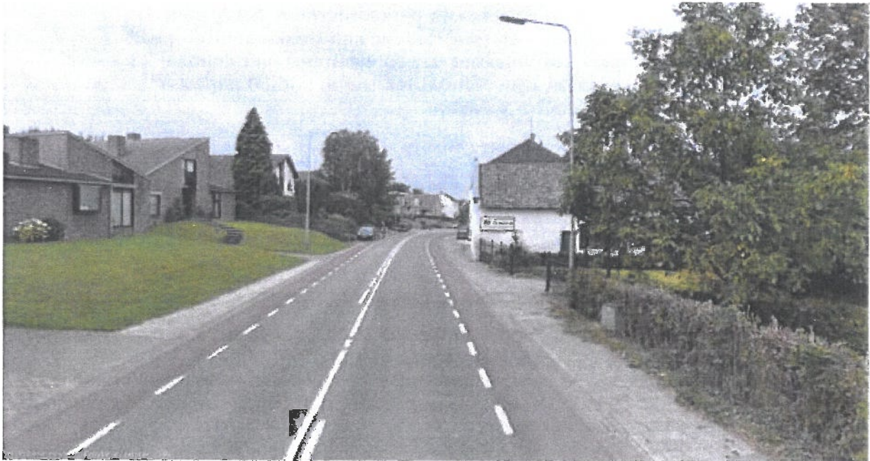
Afbeelding 18 Inrit gezien vanuit oostelijke richting.
