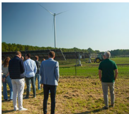
Agri-PV Symbion (foto: Vattenfall)
