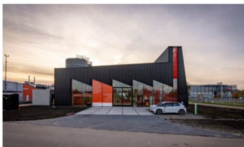
Warmtecentrale WarmteStad in Groningen
