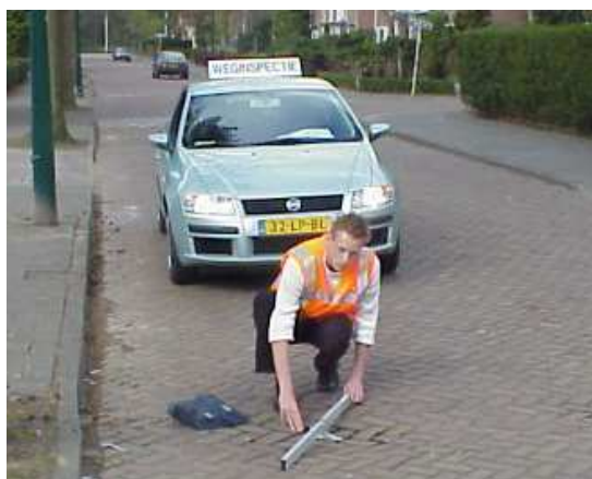
Figuur 4 Beoordelen schade tijdens globale visuele inspectie
