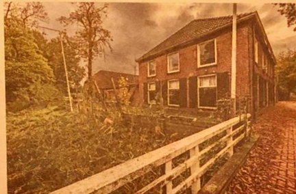
▲ Het voormalige pand van de Bierton gaat deels tegen de vlakte. Op het parkeerterrein komen 52 appartementen. FOTO FRANS PAALMAN
