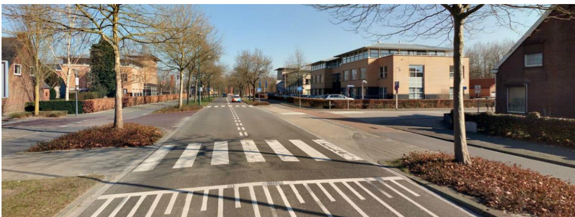
Abbeelding 1: Kruispunt Burgemeester Mollaan - Gestelsestraat, komende uit de Burgemeester Mollaan (westelijke richting)
