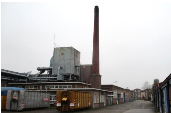
1. Schoorsteen met ketelhuis (bron: Delfgou)
