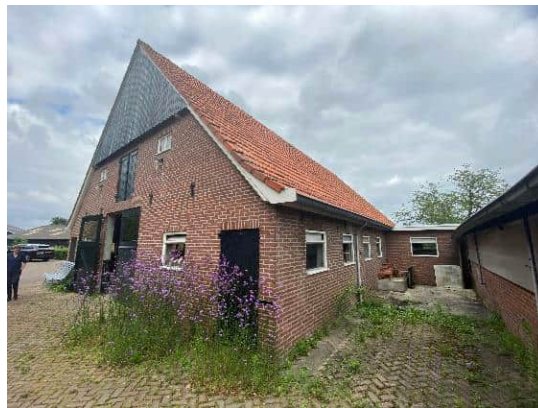
Oostgevel van de schuur
