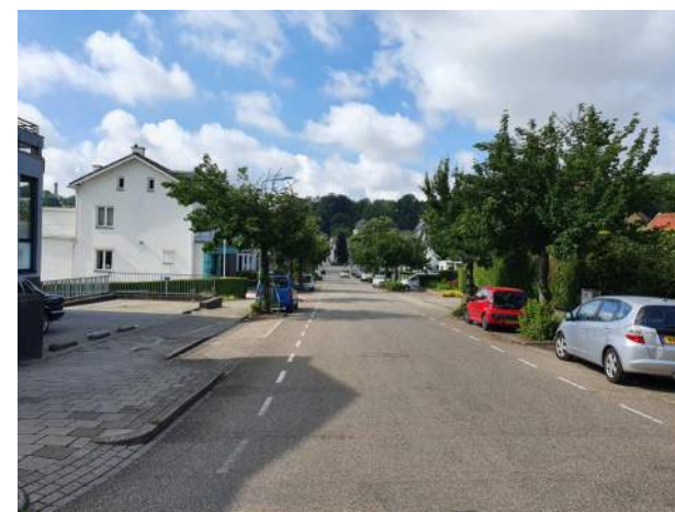
Een deel van de ontsluitingsweg rondom het centrum van Valkenburg kent een groenstructuur die niet past bij de grandeur van het oude centrum. Op de foto de Koningin Julianalaan.
