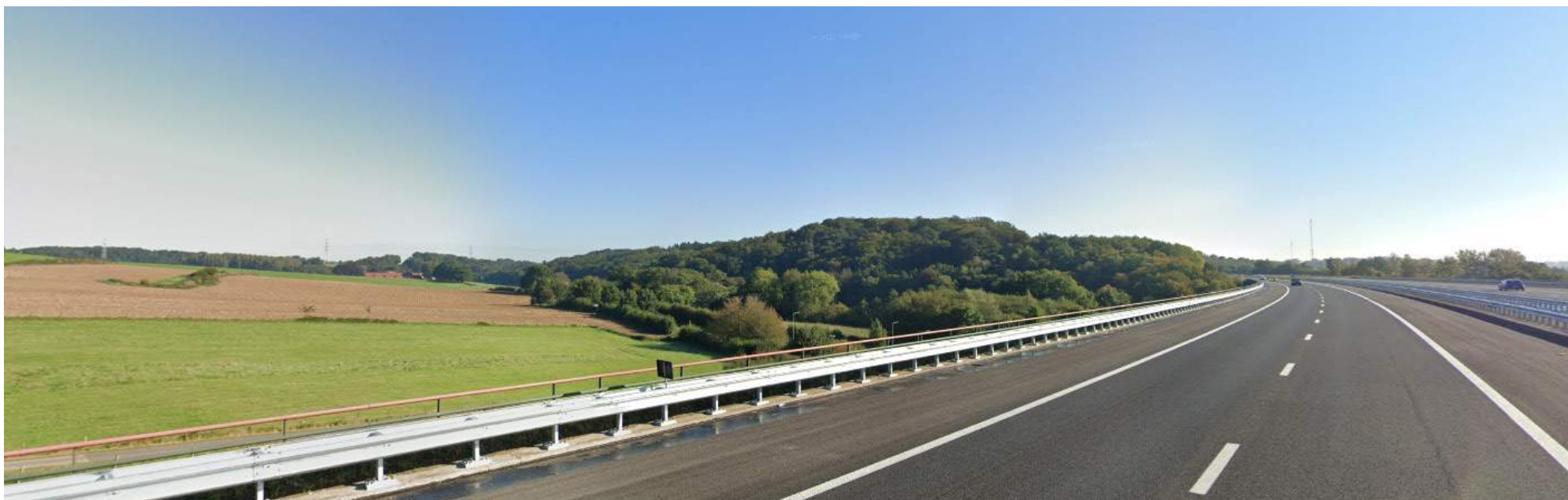
A79 kijkend richting Heerlen, zicht vanaf het dalviaduct op het Ravensbosch.
