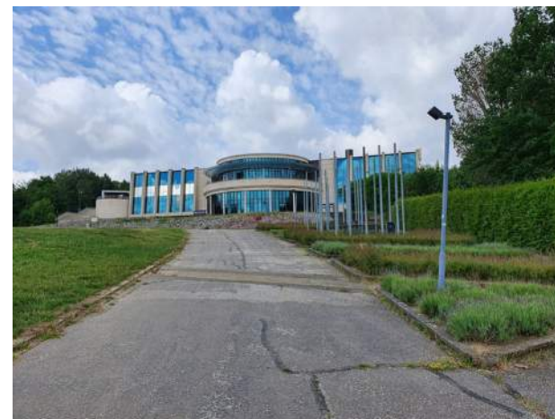
Het Kuurpark en het casino zijn destijds met veel grandeur ontworpen. Deze ontwerpgedachte past niet meer bij de huidige tijd. Daarbij is het onderhoud van het park lastig door aanwezigheid van wilde zwijnen.
