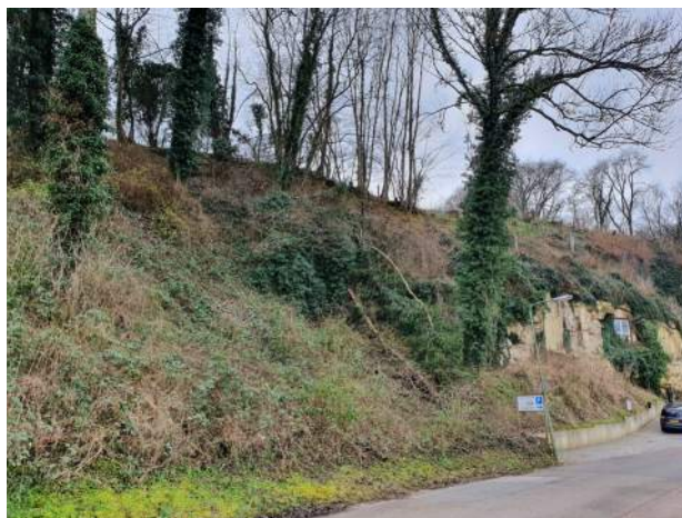
Op verschillende plekken in de gemeente zijn steile mergelwanden aanwezig, die niet tot weinig beleefbaar zijn. Op de foto de Wolfsdriesweg.
