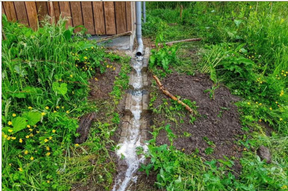
Afkoppelen regenpijp op de eigen tuin.
