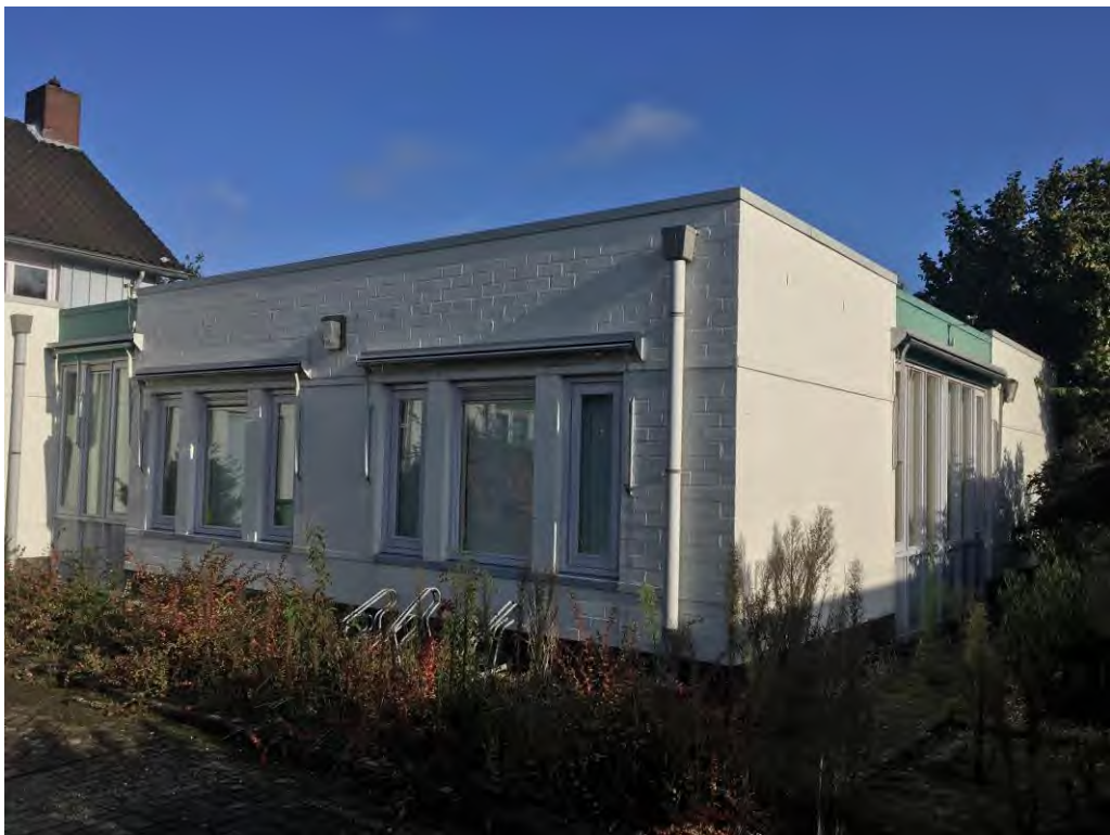
Figuur 4 Het oostelijke deel bestaat uit één bouwlaag met platdak.
