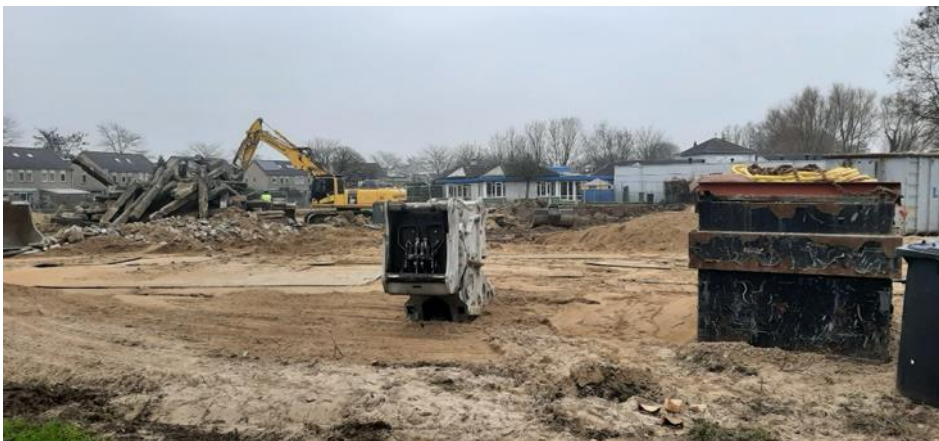
Foto genomen vanaf de bocht Walcherenstraat – fietspad. Huidige schoolgebouw wordt gesloopt en daarmee biedt de locatie ruimte voor 16 woningen.
