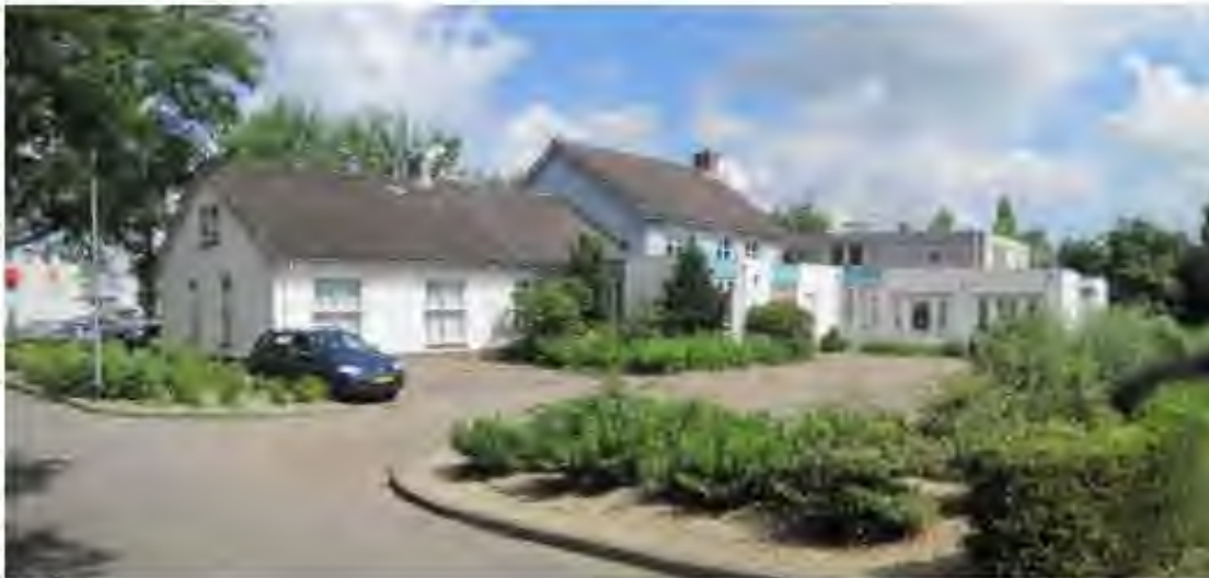
Achterzijde bestaande bebouwing (foto: Lengkeek architecten en ingenieurs)
