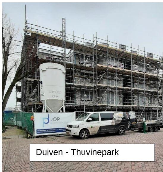
Foto genomen vanaf Thuvinepark huisnr. 105. Bouw van 15 woningen is in volle gang
