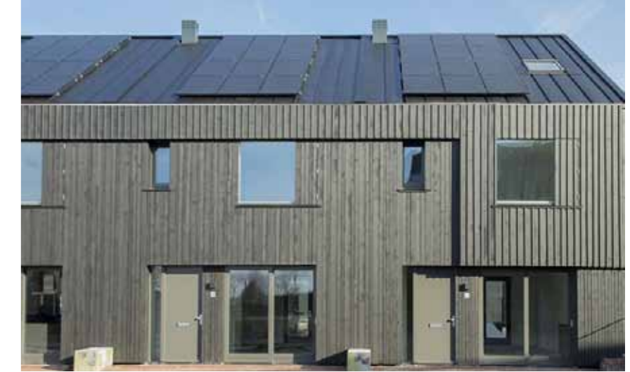
Referentie, kozijnen in de zelfde tint als de gevel, verschillende soorten gevelbekleding en negges
