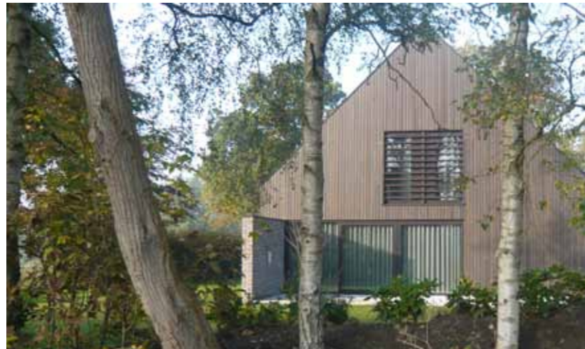
Referentie, dwarskap, lage goot, kleur gevel en kozijnen in dezelfde tint, metselwerk ondergeschikt
