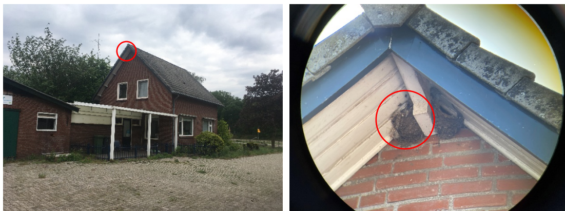
Figuur 3.7 Aangetroffen nesten van de huismus in gebouw 1 (rode cirkel).
