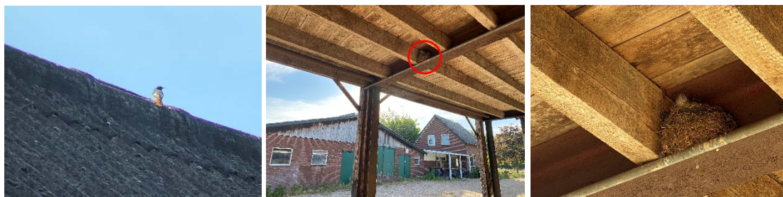
Figuur 3.11 Waarneming van een zwarte roodstaart. Zwarte roodstaart op gebouw 4 (links), aangetroffen nest van de broedende zwarte roodstaart in gebouw 2 (midden en rechts).
