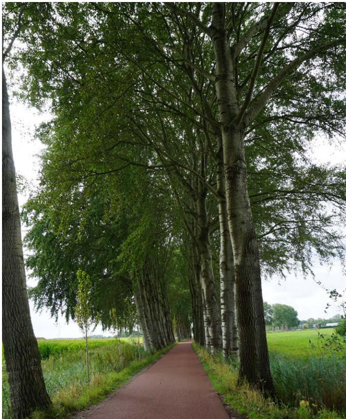
Fietsstraat de Marsdijk is de oude hoofdweerstandslijn van de Nieuwe Hollandse Waterlinie (plofsluis)
