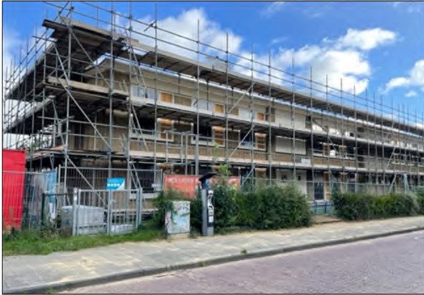
Sociale huurappartementen in aanbouw Molukkenstraat 1 (voormalig schoolpand De Buut)
