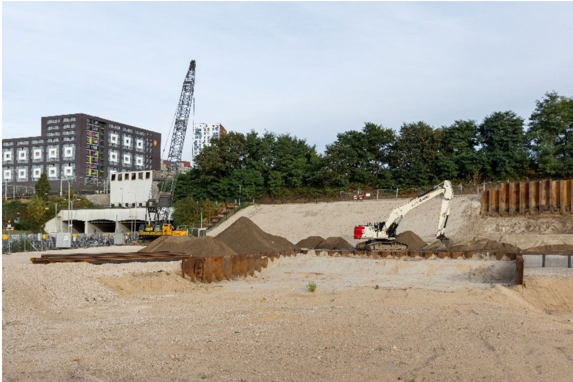
Vorbereidende werkzaamheden voor westentree en voormalige UUV
