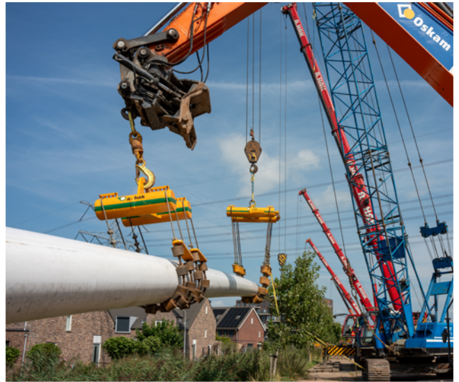
In 2024 legde HVC een nieuwe leiding aan van Sliedrecht, onder de Merwede-rivier door, naar Dordrecht. Via deze leiding wordt 100% duurzame warmte geleverd aan het warmtenet Sliedrecht.
