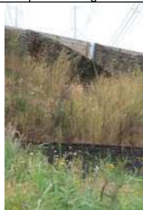
Oeverwaluwand in geluidswal A4
