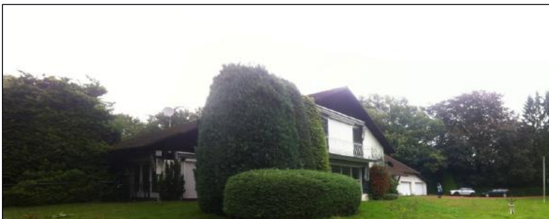
Foto aanzicht voormalige woning binnen plangebied
