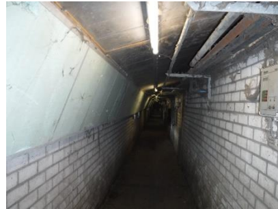
Foto 10 binnenkant dak opstal 2
