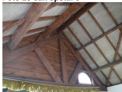
Foto 22 binnenkant dak opstal 7
