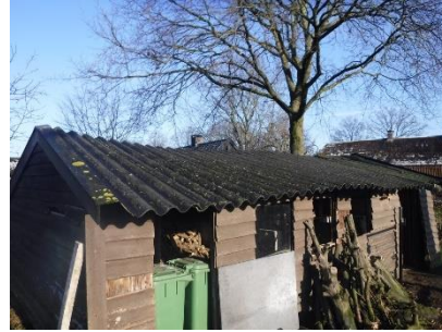
Foto 30 asbestvrij dak opstal 9
