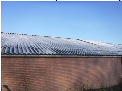
Foto 53 deel opstal 6 asbestvrij dak
