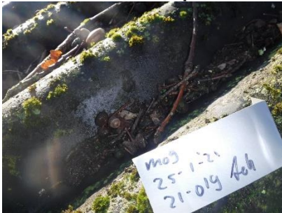
Foto 33 M09 dak opstal 10
