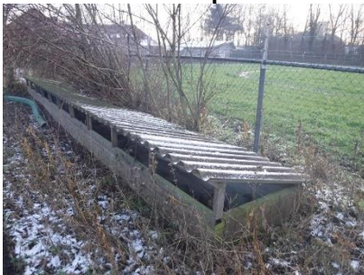
Foto 35 asbestvrije golfplaten op ventilatiegebouwtje
