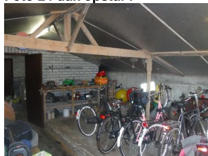
Foto 26 binnenkant dak opstal 8
