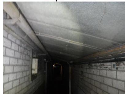
Foto 14 binnenkant dak opstal 4
