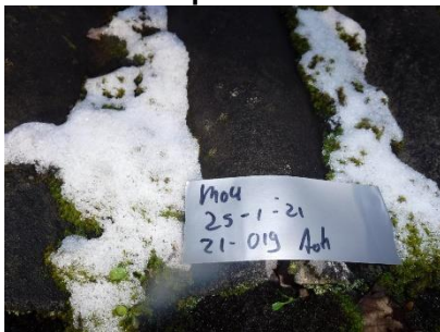
Foto 13 M04 dak opstal 4
