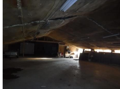
Foto 2 binnenkant dak opstal 1
