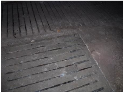
Foto 45 betonnen roosters
