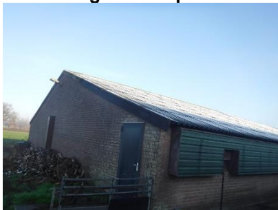
Foto 51 deel opstal 2 asbestvrij dak
