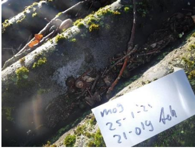
Foto 29 M08 asbestvrij dak opstal 9
