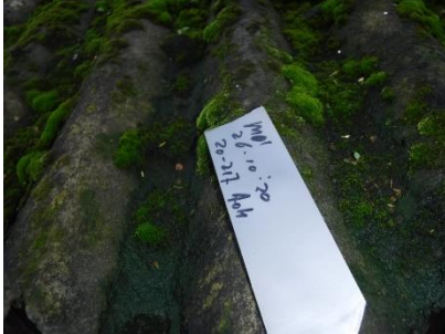
Foto 1 M01 dak opstal 1
