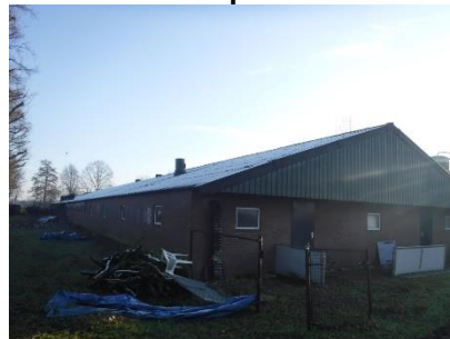
Foto 52 deel opstal 4 asbestvrij dak
