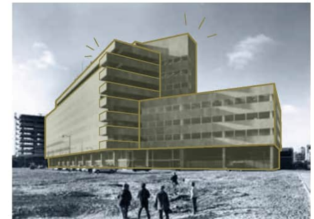
2. Contrast tussen vlak en plastiek in gevel. Kenmerkende open balkons als scharnier tussen twee gebouw vleugels
