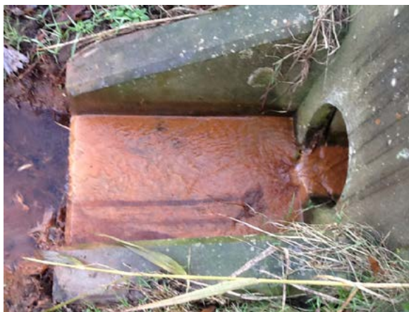
IJzerafzetting in en bij het uitstroompunt van een drain. De belangrijkste oorzaak van verstopping
