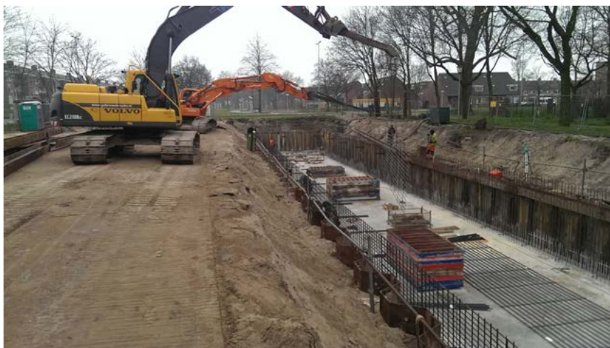
Aanleg bergbezinkbassin Springerpark
