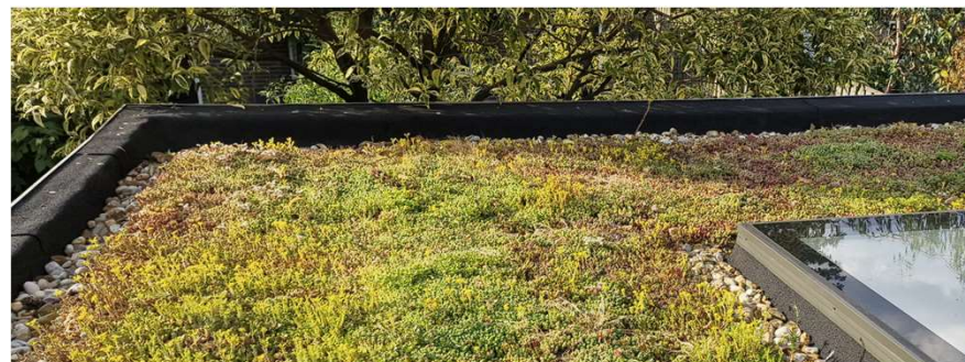
Groen dak met sedum
