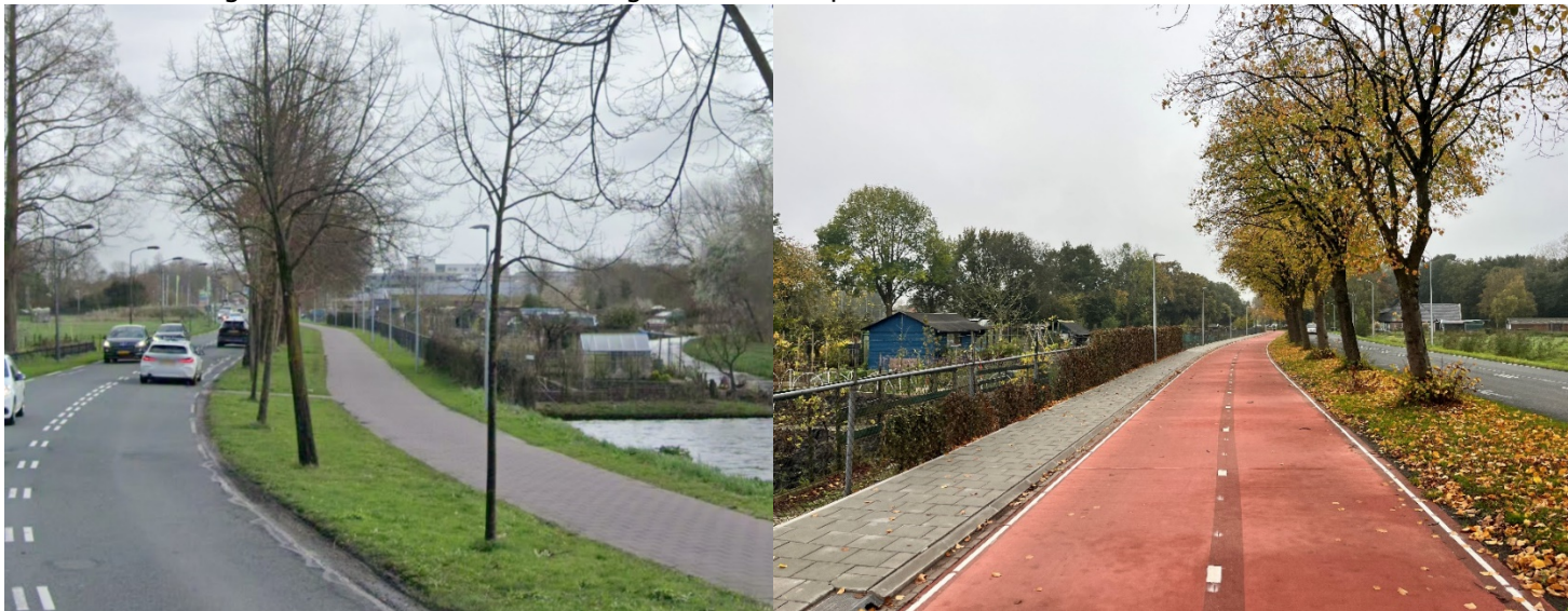
Figuur 1: Berkhouterweg voordien en na aanpak met subsidie subsidieregeling Kleine Infrastructuur
