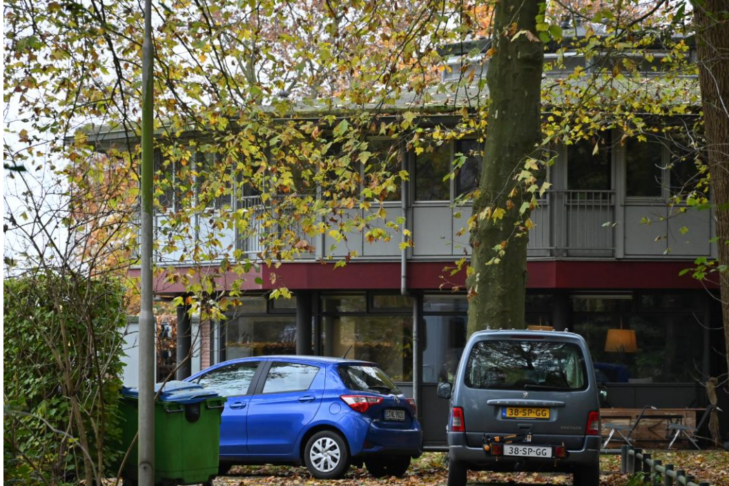
Linkerzijde van zuidwestgevel.
