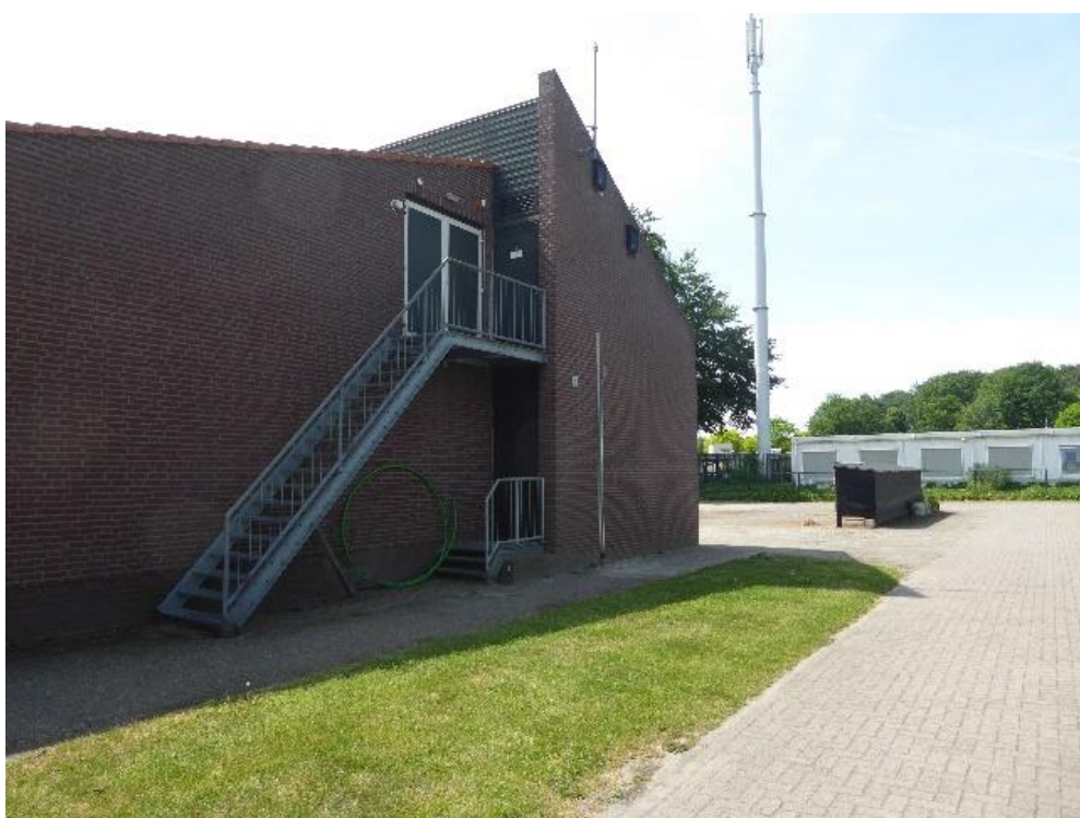
Afbeelding 7. Impressie van de bestaande bebouwing binnen deelgebied 2.
