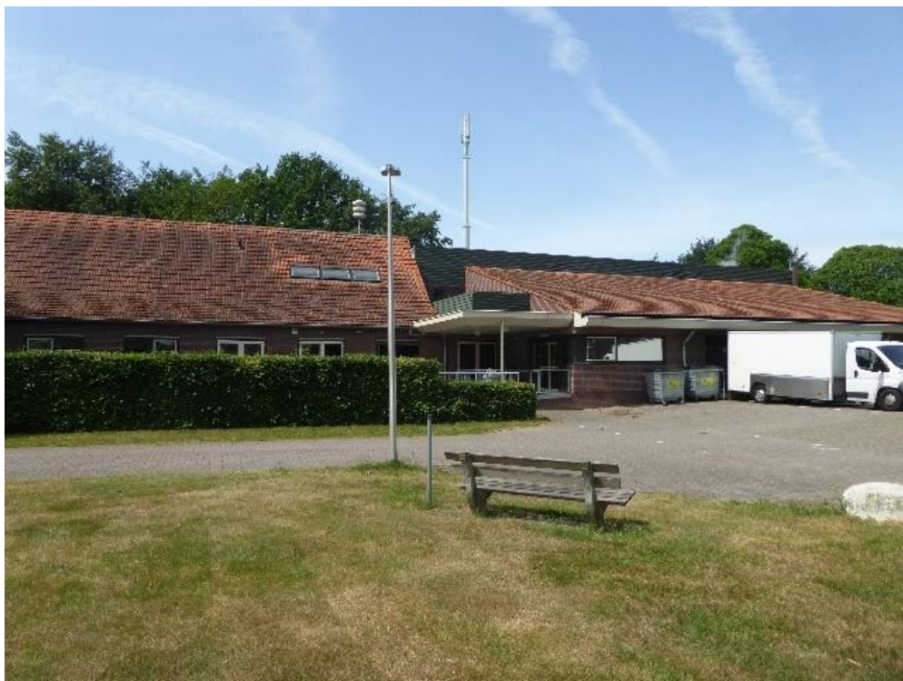
Afbeelding 5. Impressie van de bestaande bebouwing binnen deelgebied 2.
