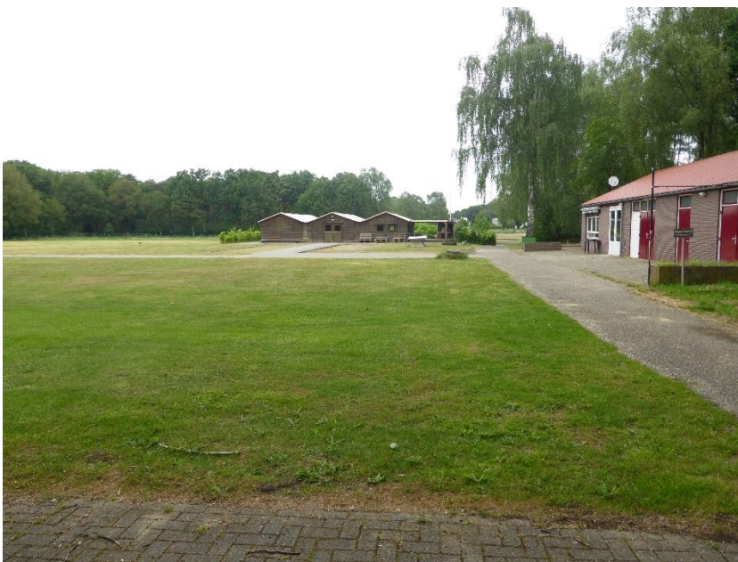
Afbeelding 16. Impressie van de bestaande bebouwing binnen deelgebied 6.
