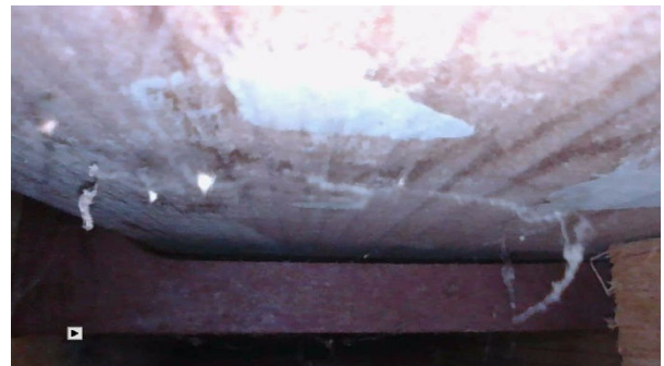
afb. 3.7 schimmelsporen (beeld endoscopie).
