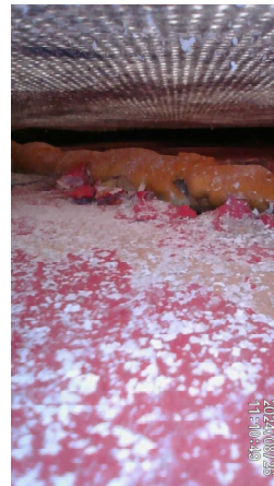
afb. 3.5: locatie purnaad dakplaat (beeld endoscopie).
