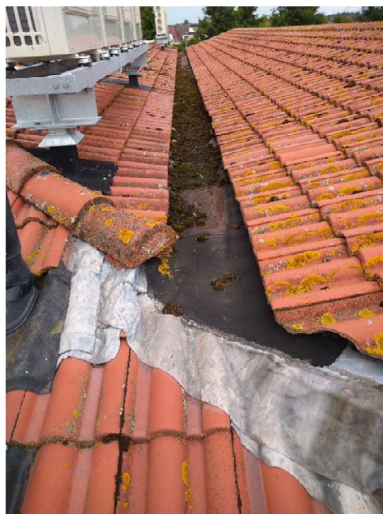
afb. 2.8: aanluiting tussengoot op pannendakvlak.
