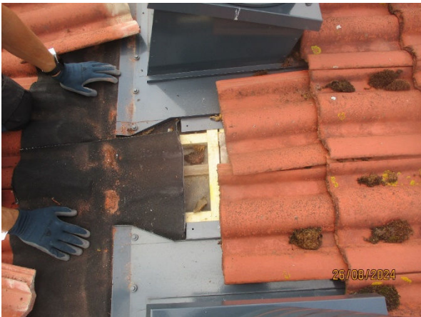
afb. 2.25: strook DPC folie over laatste panlat.
