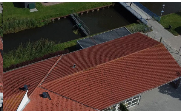
afb. 2.4: overzicht dak entree onderbouw.
