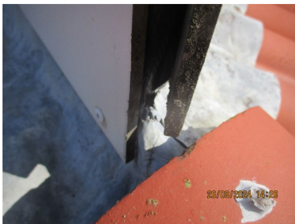
afb. 2.15: tresp aansluiting staat open mogelijke toegang hemelwater.
