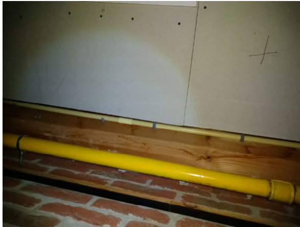
afb. 3.4: lekplaats goring boven syteemplafond.
