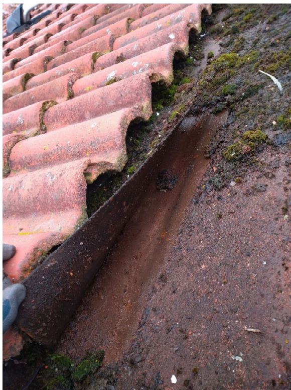
afb. 2.11: losse folie loopt door in goot.
