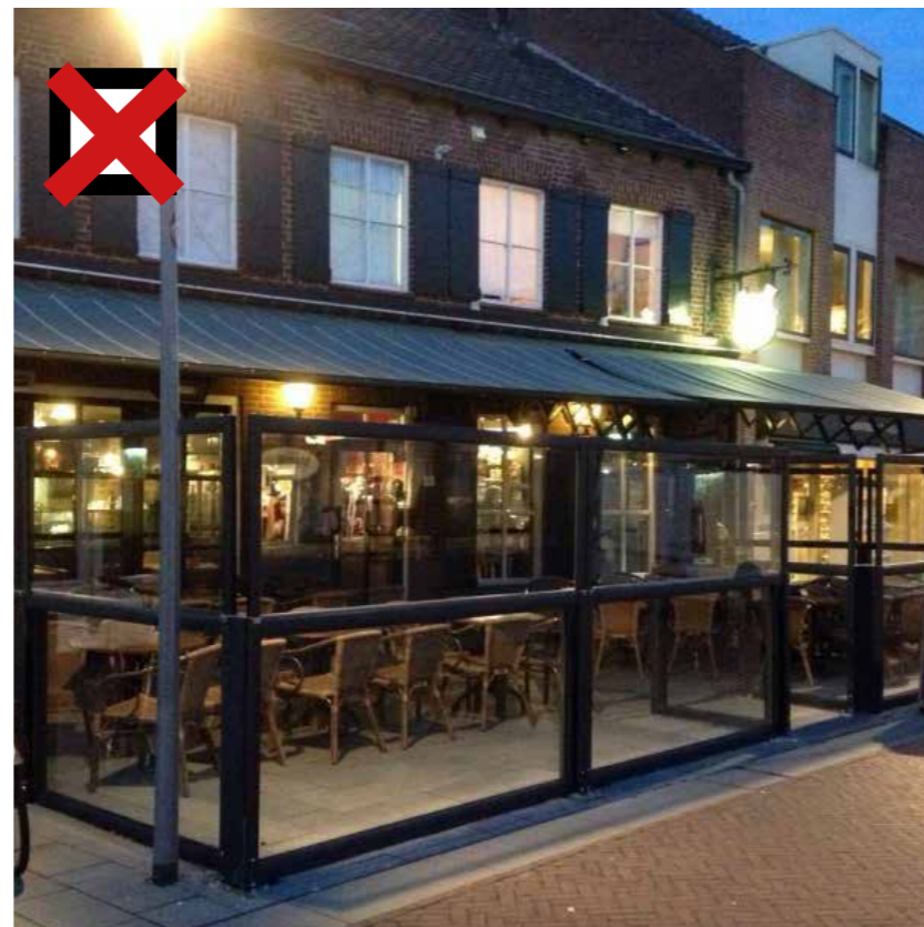
Dichtmaken voorzijde niet toegestaan
