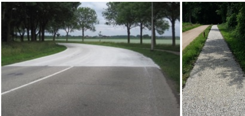
Foto: Een stuk wegdek elders in het land voorzien van een witte toplaag.
