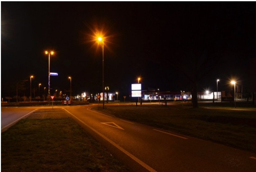
Foto: Led display aan de Rondweg Zuid in Winterswijk. Deze kan de aandacht van de weggebruiker afleiden. Ook kan het zorgen voor lichtvervuiling of lichthinder.
