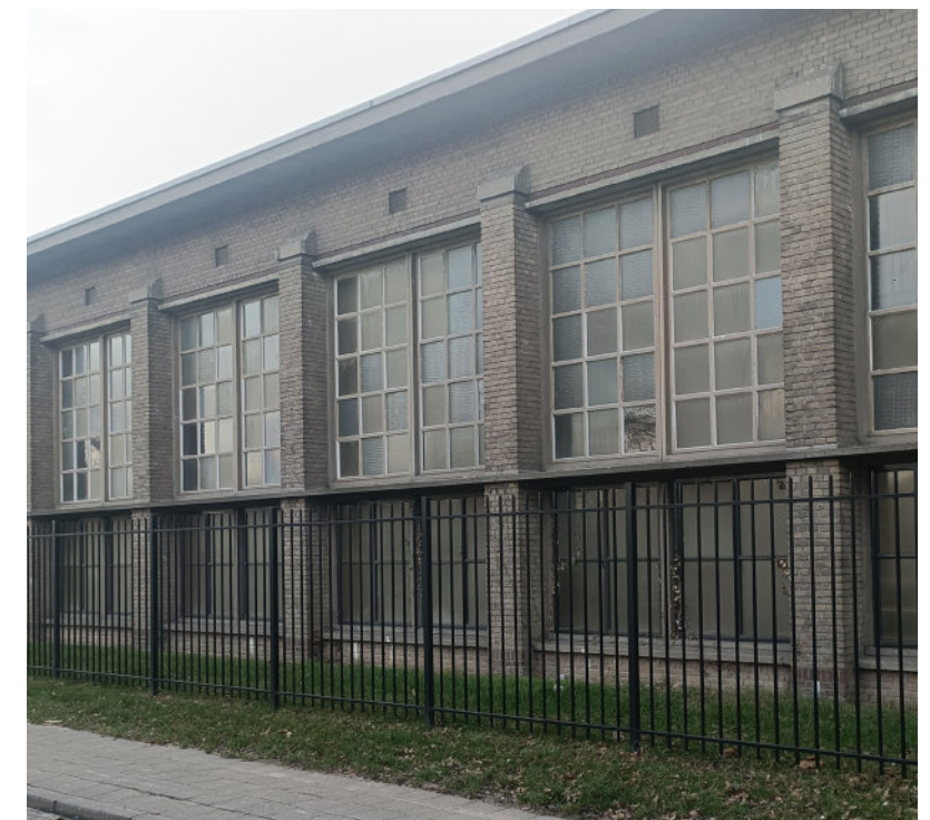
referentie DAR gebouw Nijmegen (de Biezen)
