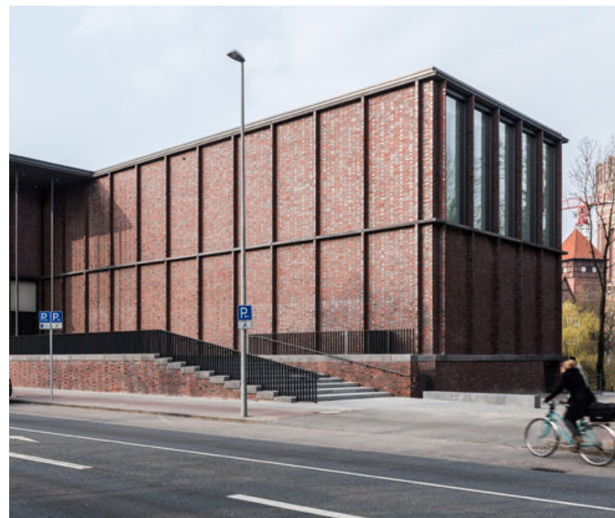
verticale ribben en horizontale banden in gevelontwerp
