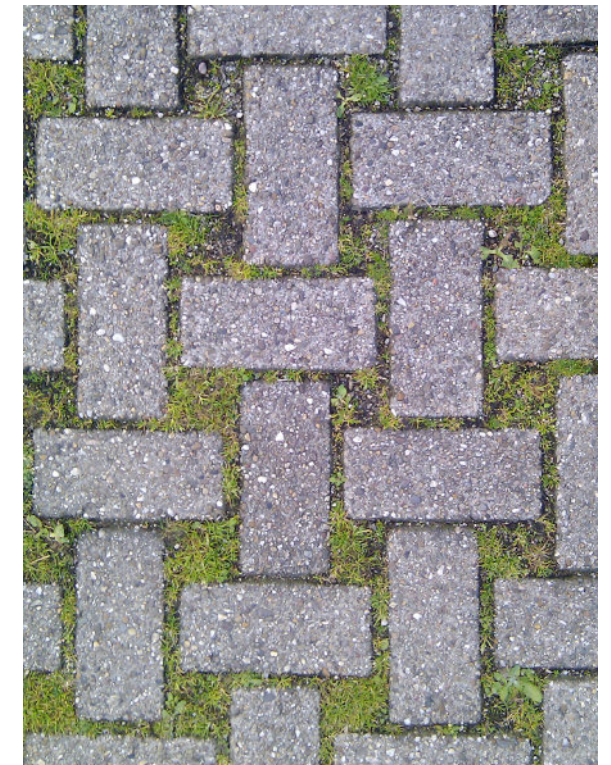
speciaal verband voor half verharding met klinkers
