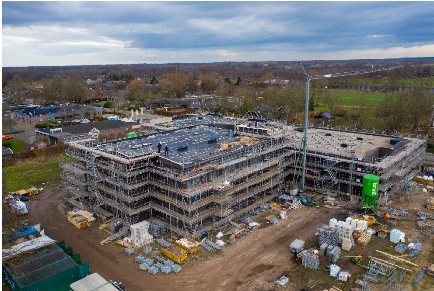
Woonzorgcentrum Dwarsakker in aanbouw, Zwarteboek (foto van de Kolk, jan. 2021)
