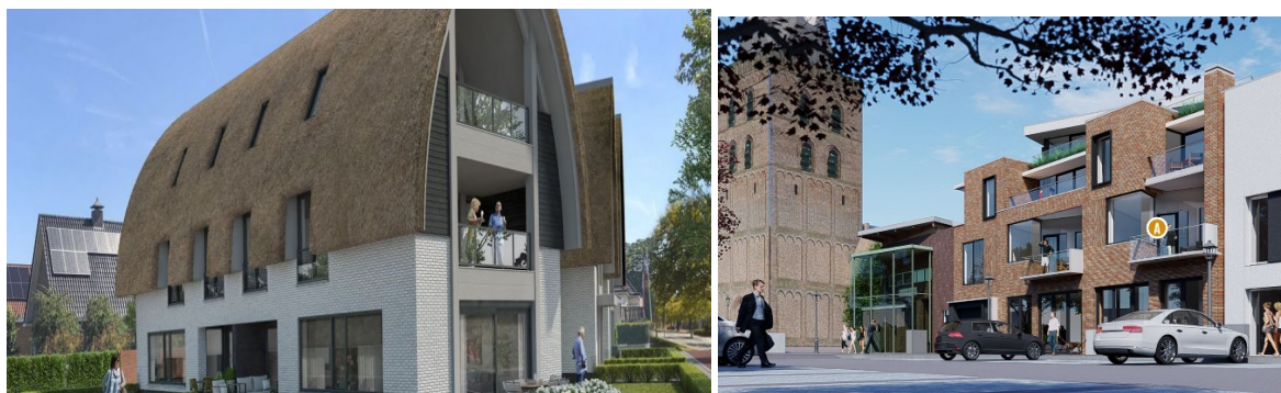
Villa Thorbecke (links) en nieuwbouw Torenplein (rechts), Barneveld
