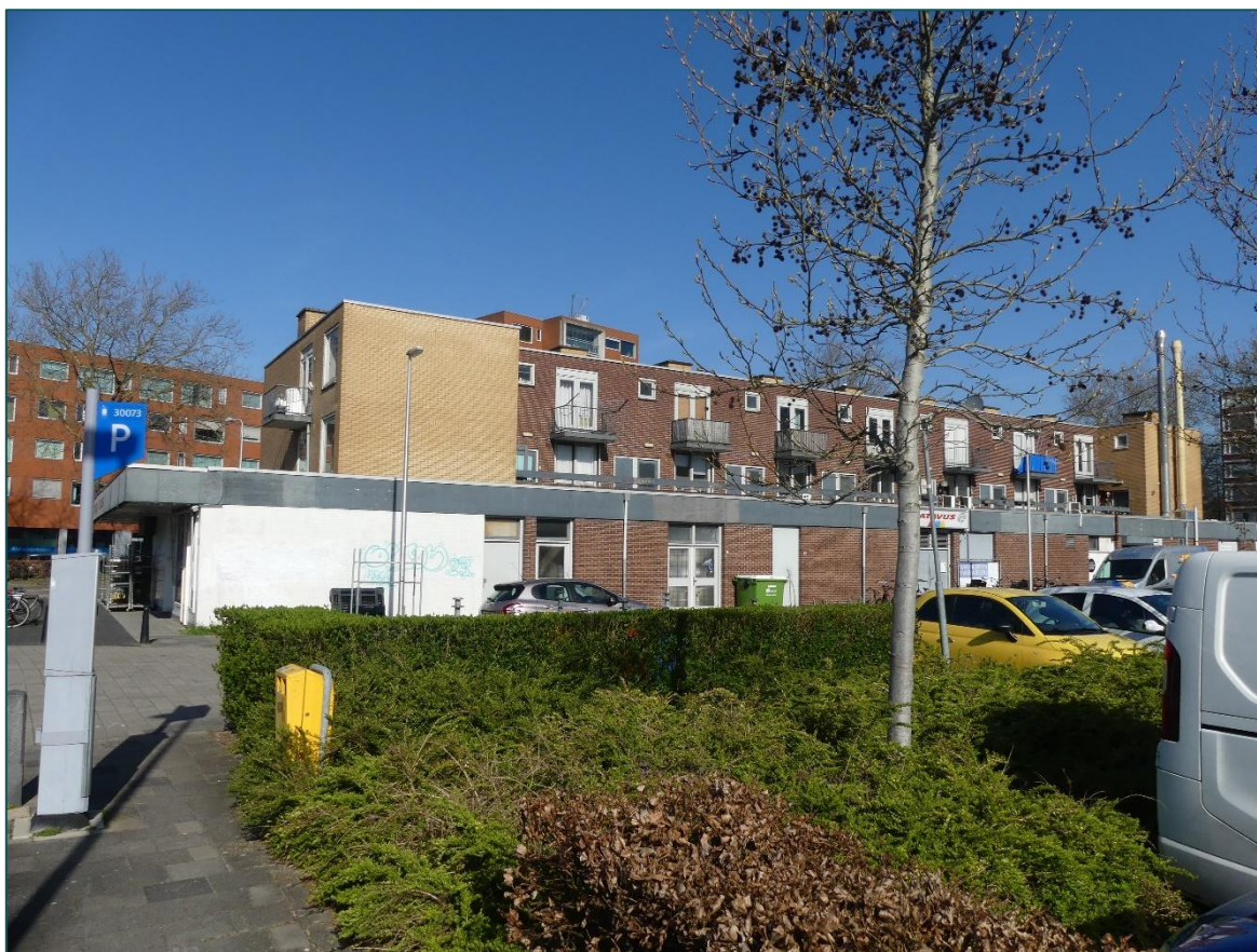
Figuur 3 Binnen de planlocatie zijn er een aantal groenstructuren aanwezig, bestaande onder andere uit buxus- en beukenhagen. Deze worden weggenomen in de beoogde ruimtelijke ingreep.
