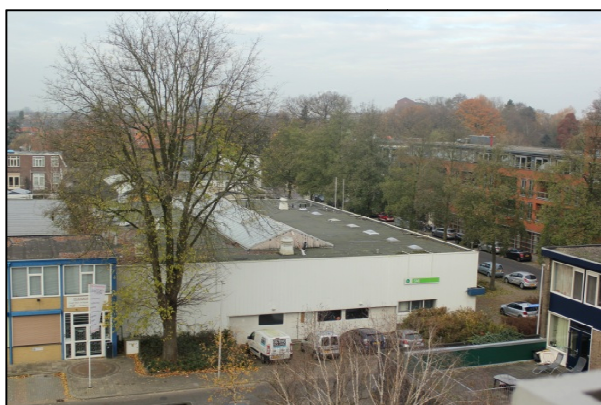
Foto 3: bovenzijde te slopen gebouw
