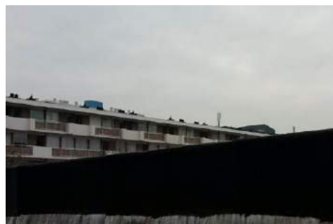
Foto 41 | Foto voor bron Dakbedekking
