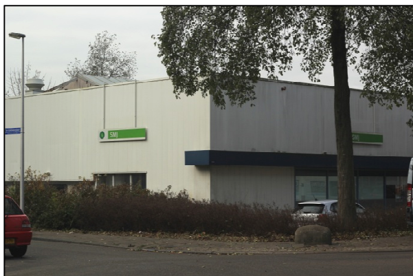
Foto 1: voorzijde te slopen gebouw
