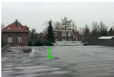
Foto 40 | Foto voor bron Dakbedekking
