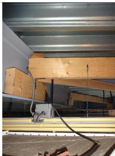
Locatie 3 – Overzicht dakconstructie
