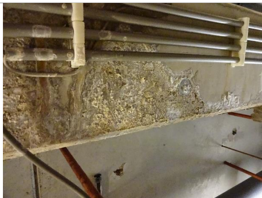
Balk in slechte staat, aantasting (zie eerdere rapportage uit archiefonderzoek)
