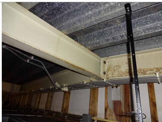
Locatie 1 – Overzicht dak
