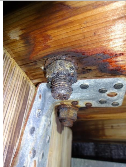
Aansluiting spant – drukboog in zeer slechte staat
