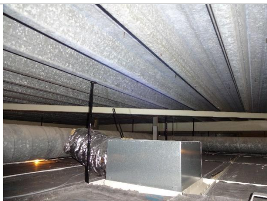
Locatie 2 – Overzicht dakplaten en ophangconstructies
