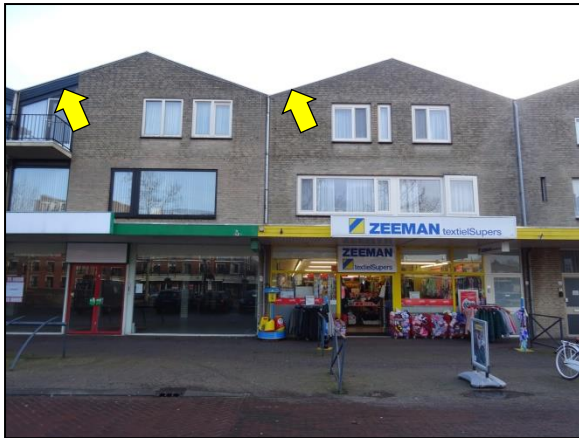
Figuur 12. Potentiele verblijfplaats voor gebouwbewonende vleermuizen in de spouwmuur, achter betimmering en onder de dakrand.
