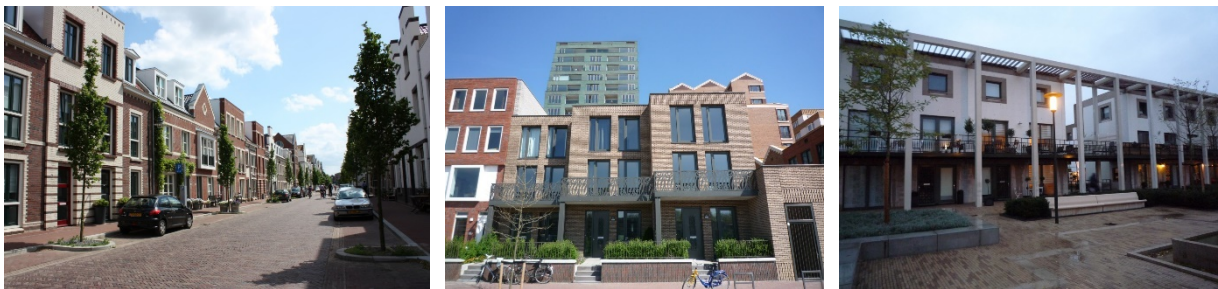
Figuur 7: Grondgebondenwoningen in een stedelijk woonmilieu
