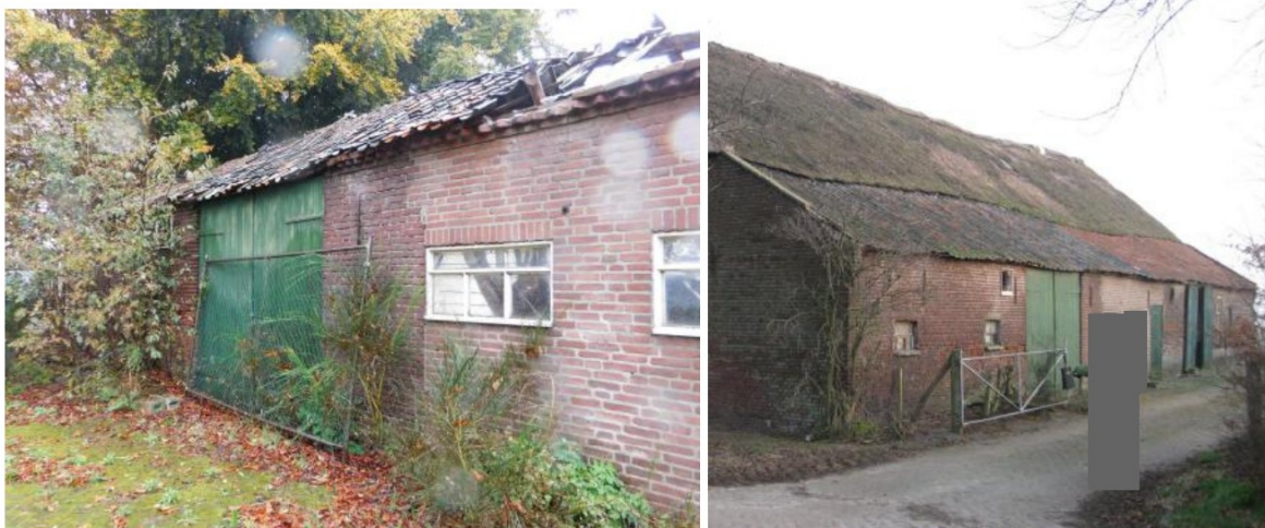
Figuur 7 - Links de huidige situatie van (een deel van) de rechter zijgevel. Te zien is de oude toegangspoort en de plaats waar een poort is dichtgemetseld. Aan de bovenzijde is de muizentand te zien. Rechts de situatie in 2008.
