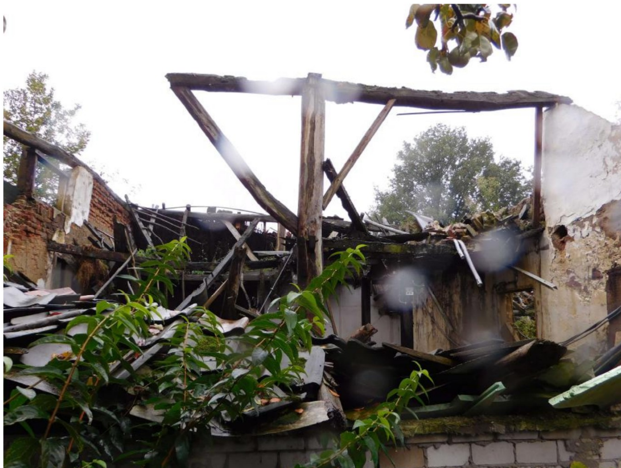
Figuur 9 - Interieur Duifhuizerweg 22A - te zien is het restant van het gebint in het woongedeelte, links de achtergevel, rechts de brandmuur.
