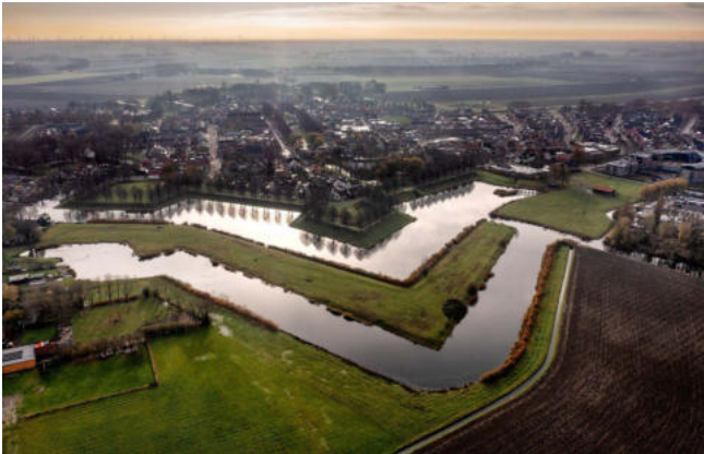
Luchtfoto van de waterstructuur die de vestingwerken hebben gevormd
