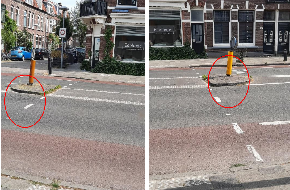
Figuur 5: Schade aan het wegdek in de Willem van Noortstraat
