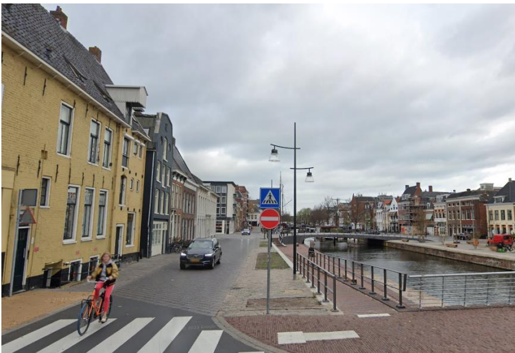
Figuur B1.12: Schuitendiep Groningen (na reconstructie); in de verte is de nieuwe brug over het Kattendiep zichtbaar.
