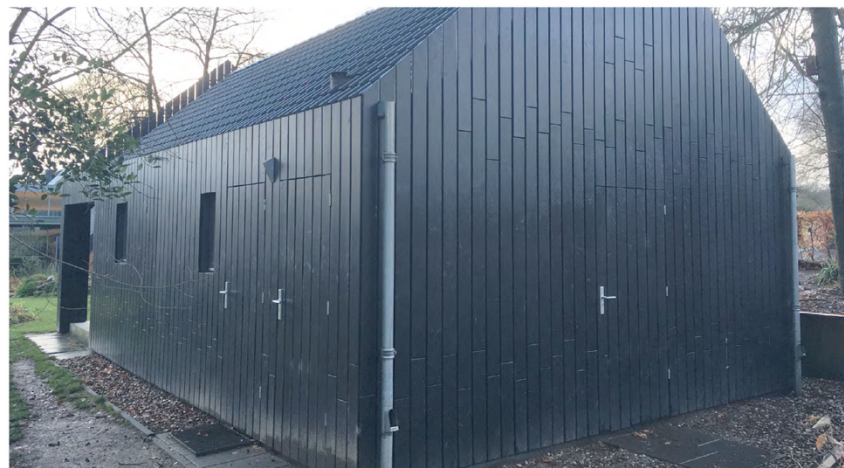
De bijenstal kent een strakke uitstraling, net als het gebouw op bovenstaande foto. De deur van de bijenstal zal op dezelfde manier worden geplaatst als op deze foto en valt in de wand. Wand en deur vormen zo één geheel.
