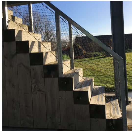
Trap van douglashout in het 'paviljoen'
