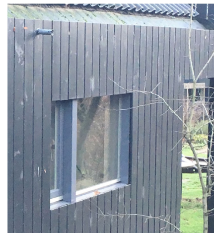
Het kozijn valt terug ten opzichte van de houten betimmering, zoals op deze foto ook te zien is.
