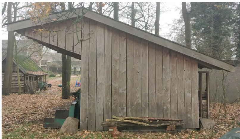
De bijenstal zal worden gerealiseerd met onbehandeld douglashout, zoals op deze foto te zien is. Bij de bijenstal worden de naden echter afgedekt met een plank, waardoor een dichte wand ontstaat. Daarbij zal de bijenstal, net als de stal op de foto, een asymmetrisch zadeldak hebben.
