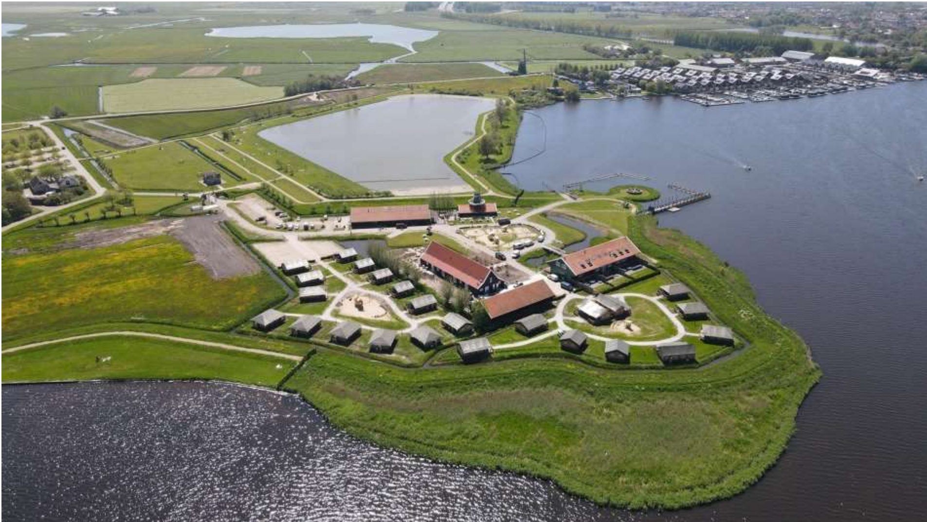
Figuur 9 Luchtfoto van Erfgoedpark De Hoop en jachthaven Uitgeest
