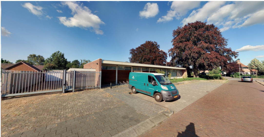
Figuur 2.2 plangebied gezien vanaf de Christianalaan met de parkeerplaatsen van het voormalige politiekantoor.
