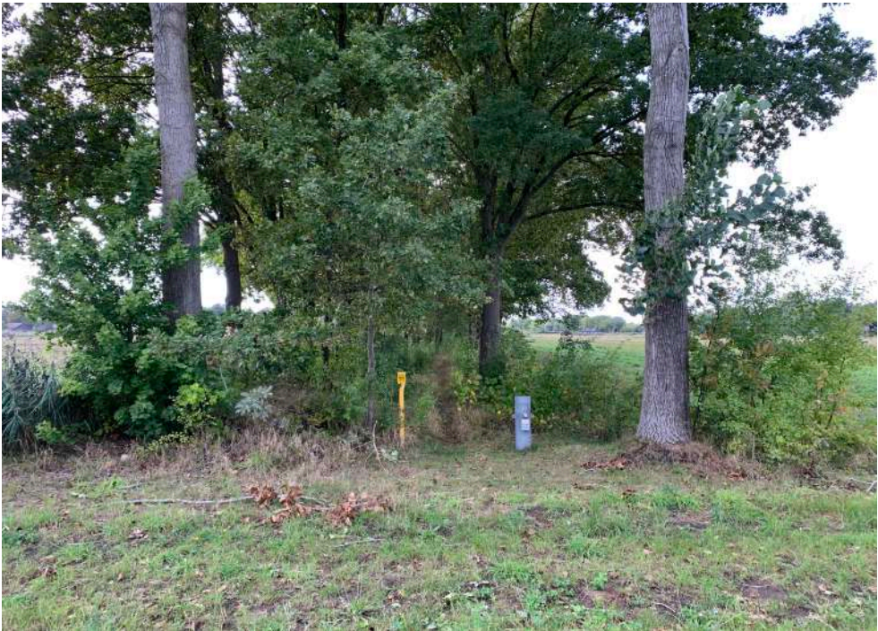
wandelpaadje en aanduiding gasleiding door houtwal
