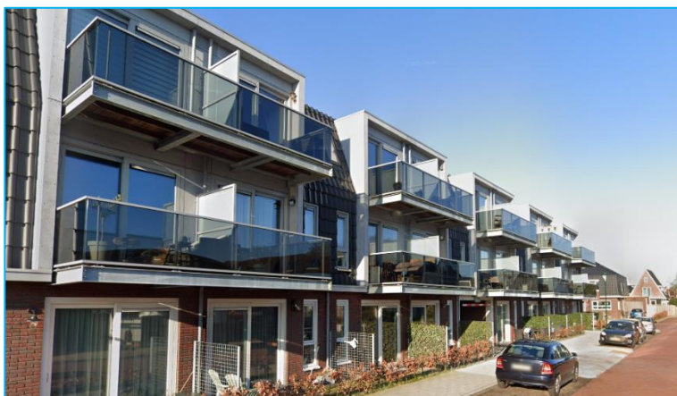
Figuur 4 Gevel tegenovergelegen gebouw
