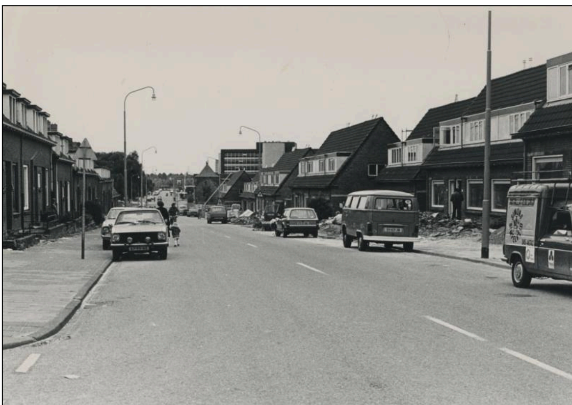
De renovatie in de Kasteellaan, jaartal 1979.
