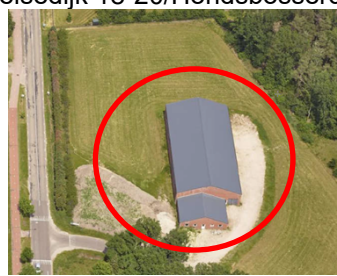
Figuur 4 Hondsbosserdijk 1a, te slopen bebouwing
