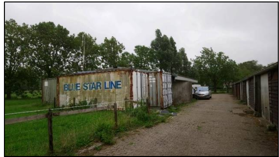
Afb. 2.2. Te verwijderen silo met containers
