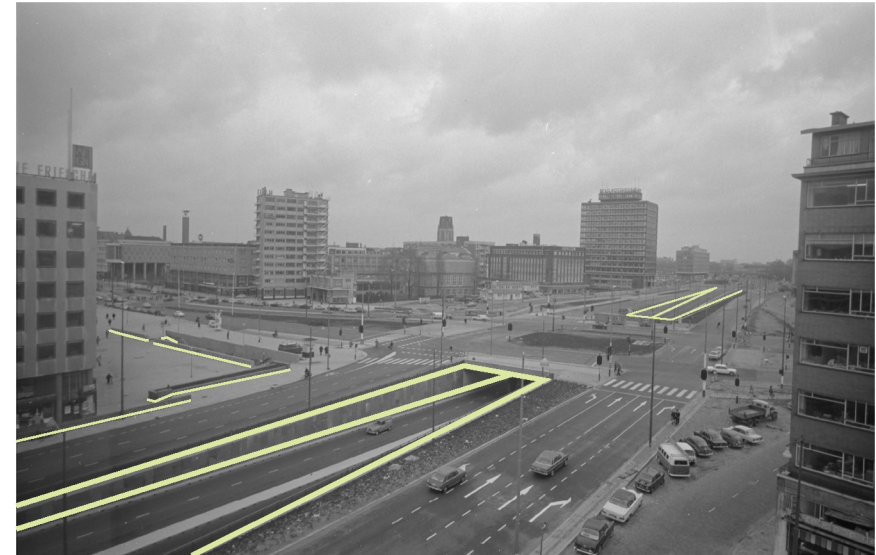
1968 komst autotunnel en metrostation Churchillplein zorgt voor obstakels in de buitenruimte
