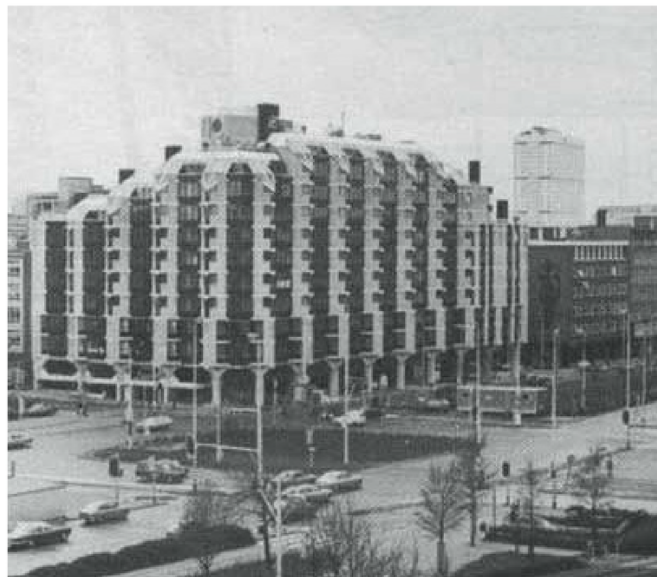
Appartementengebouw De Nieuwe Veste vlak na oplevering in 1980.
