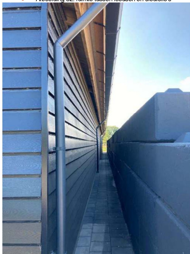
• Afbeelding 32: ruimte tussen loodsen en sleufsilo's
