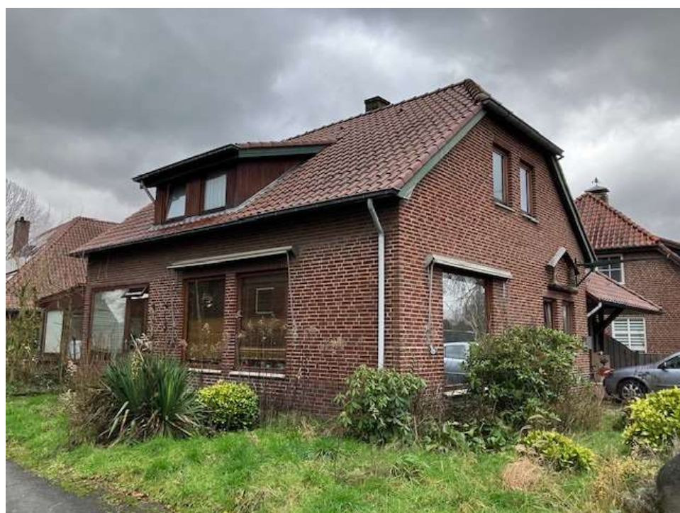
• Afbeelding 29: linkerzijgevel en voorgevel woning, blijft behouden. Op achtergrond rechts de woning van de buren. Op achtergrond links appartementengebouw
