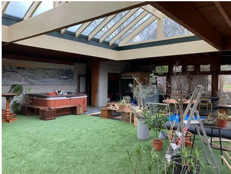
• Afbeelding 4: ruimte van het voormalige binnenzwembad, wordt gesloopt
