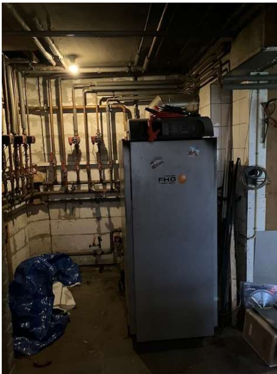
• Afbeelding 25: voormalig ketelhuis, sinds 2019 niet meer in gebruik
