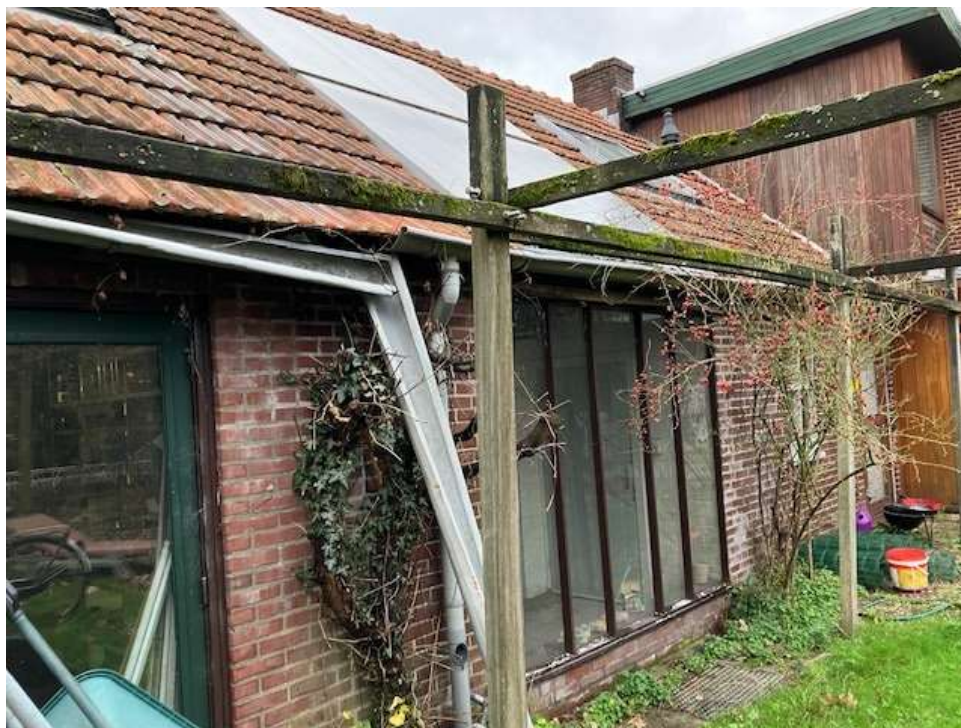
• Afbeelding 26: te slopen bouwdeel tussen woning en appartementen
