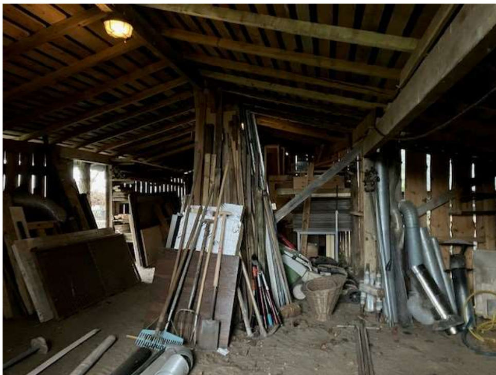
• Afbeelding 15: binnenzijde te slopen schuur
